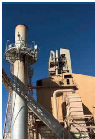
Además de resistir al ataque corrosivo el revestimiento debe promover una barrera física a la penetración de los gases ácidos evitando el ataque de la chapa y del anclaje. El anclaje es hecho en acero inoxidable, lo que ayuda en la protección.
