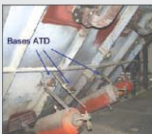
Rampa do forno
