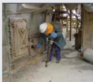
Duto de ascensão
